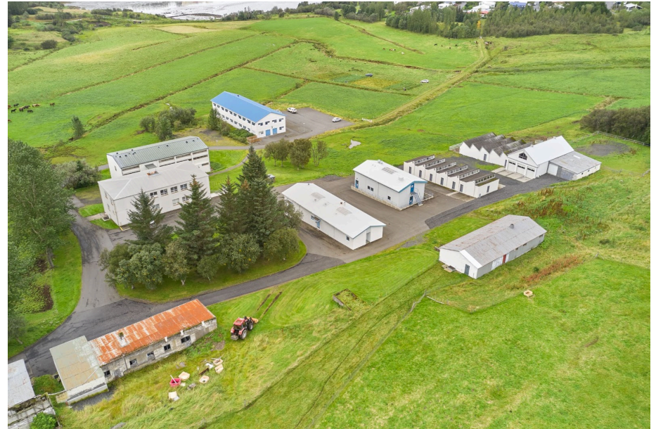
Mynd 30. Horft til vesturs yfir Keldur í átt að Grafarvogi.
