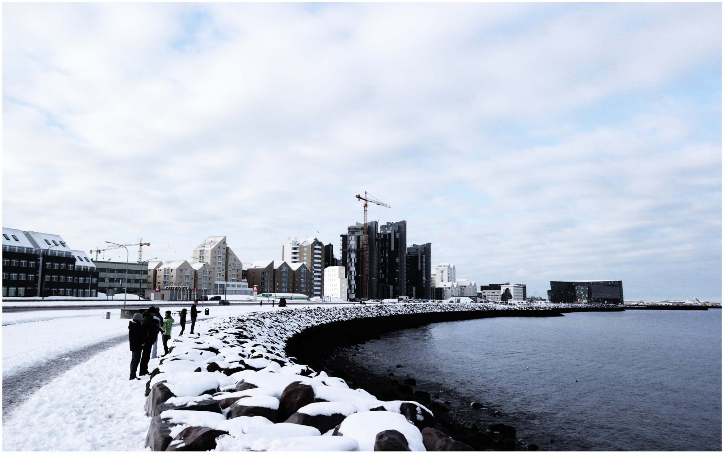
HORFT AÐ SKIPULAGSSVÆÐI FRÁ GÖNGUSTIG VÍÐ SÆBRAUT AUSTANVERT.
