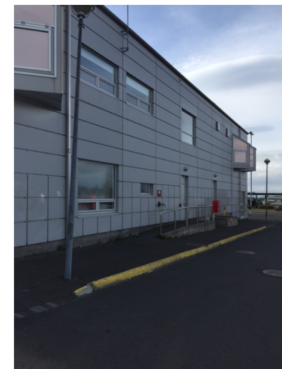
Austurhlið byggingarinnar snýr að bílastæðunum. Þar er líka starfsmannainngangur Póstsins.
