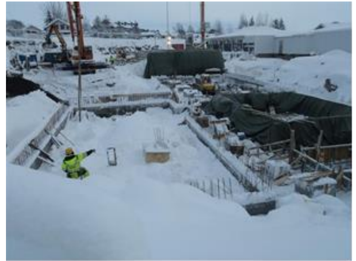
Undirstöður sundlaugakerja í lok desember 2015.
