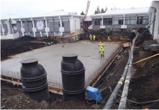
Botnplata félagsmiðstöðvar í nóvember 2015
