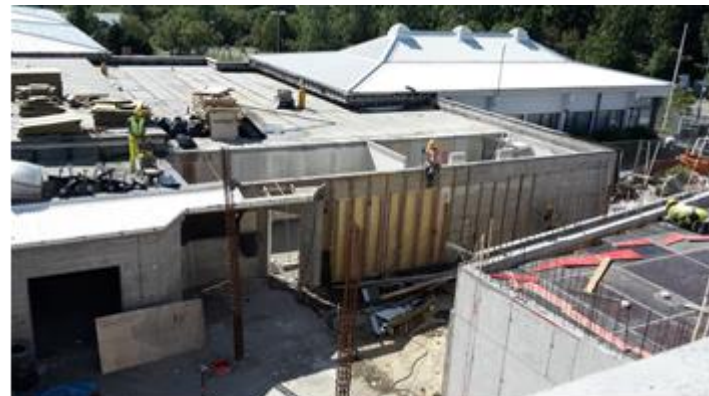
Júlí 2016. Verið að móta nýtt anddyri og aðalinngang skólans.
