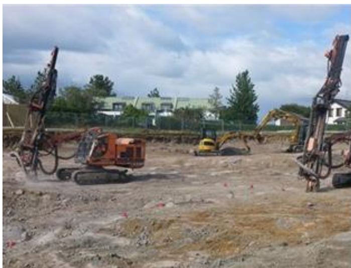
Borað fyrir sprengihleðslum. Júní 2015
