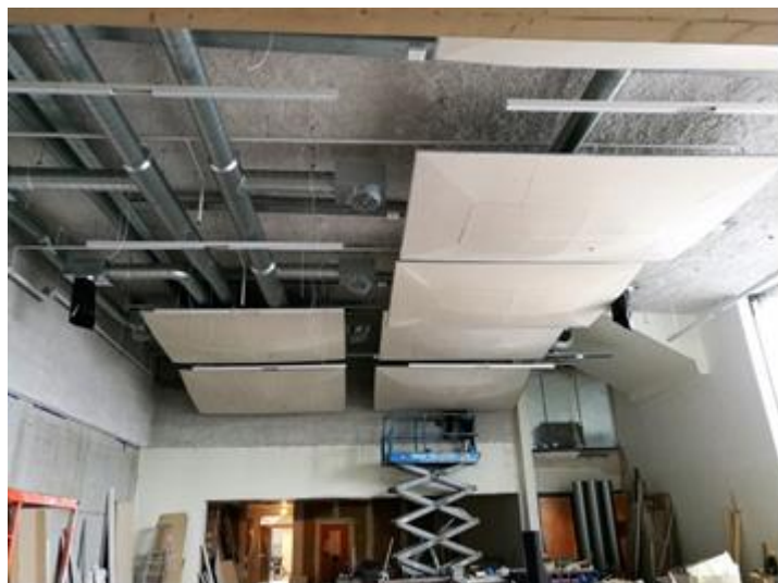
Í nýjum mat- og hátíðarsal var lögð mikil áhersla á góða hljóðvist en jafnframt góðan hljómburð. Sérhannaðir hljóðskyldir jafna flutning hljóðs um rýmið og bassagildirur jafna út lægra tónsviðið.
