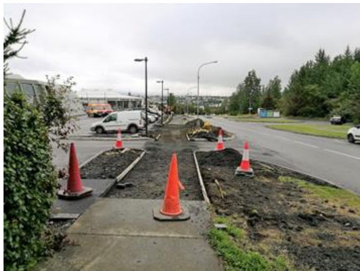
Unnið við bílastæði og aðkomu í ágúst 2018.
