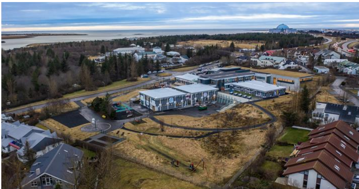
Horft yfir lóð Klettaskóla og viðbyggingu til norðvesturs (des 2018)
