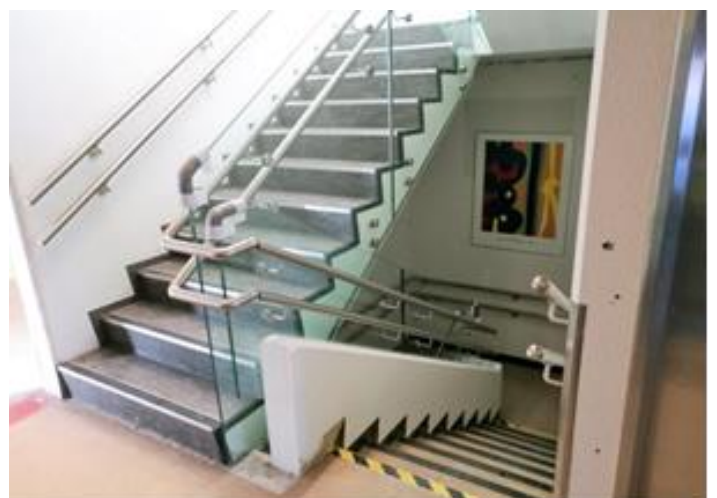
Nýtt stigahús var steipt upp sunnan megin í stjórnunarálmum. Það tengir saman viðbyggingu á efstu hæð við eldra skólahús. Janúar 2018.
