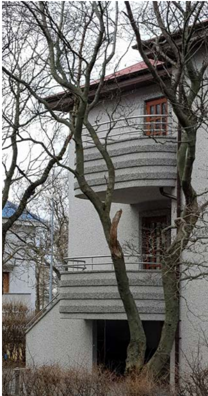
MYND 10 Einföld og falleg hækkan á svölum með láréttum stálörum.
