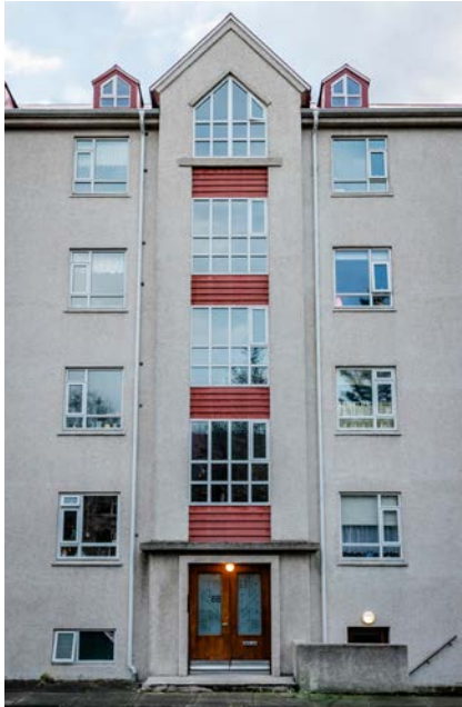
MYND 14 Inngangur og stigahús í fjölbýlishúsi við Birkimel.
