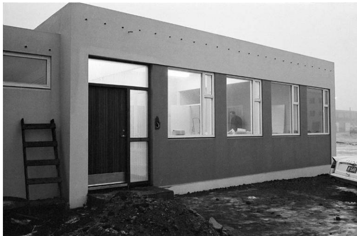
Hafnarböðin við Grandagarð – húsið eins og það leit út nýbyggt. 106
