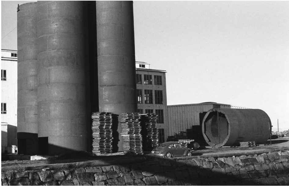
Mjöltankar settir upp við síldarverksmiðjuna að Grandagarði 20 árið 1976. 64
