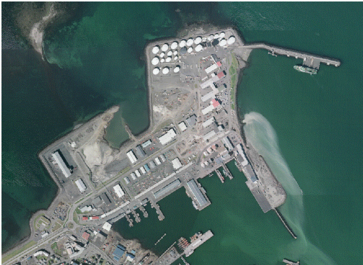
Loftmynd af svæðinu frá 2005. Lýsi hf. hefur byggt verksmiðjuhús sitt vestast á nýju uppfyllingunni og einnig er risið verslunar- og lagerhúsið að Fiskislóð 3. Verið er að gera nýja uppfyllingu við Nordurgarð. 145
