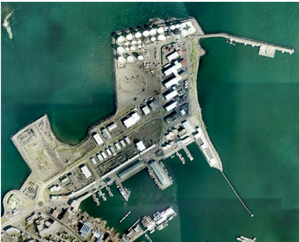
Svæðið á loftmynd frá 2002. Hér sést að búið er að byggja á nýrri uppfyllingu við Fiskislóð suðvestanverða og að byrjað er á nýrri landfyllingu til norðurs. 144
