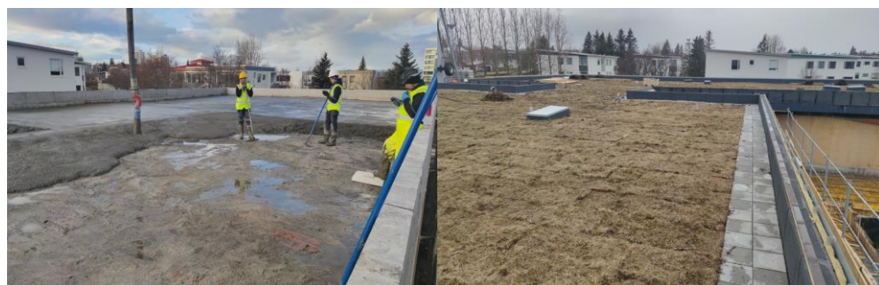
Á vinstri mynd er verið að steypa halla á þakið haustið 2021 og myndin til hægri sýnir lokafrágang á þaki vorið 2022.
