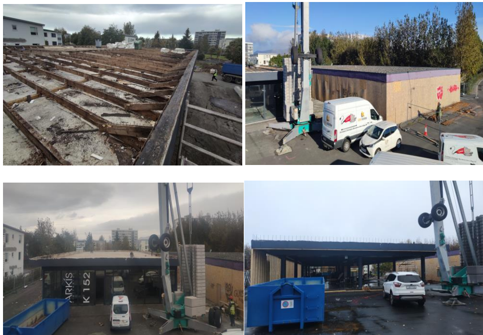
Myndirnar að ofan eru af Kleppsvogi 150-152 í upphafi framkvæmda haustið 2021.
