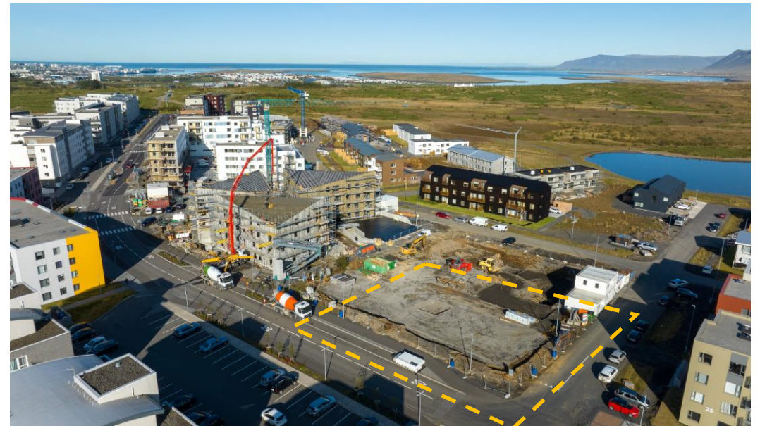
Haustið 2023 var jarðvinna hafin vegna fyrstu 36 leiguíbúða Blævar við Skyggisbraut 21-23 í Úlfarsárdal. Verklok eru áætluð um áramót 2024-25.
