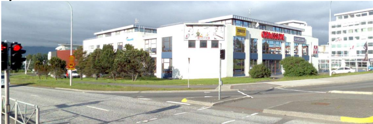
Séð frá horni Kringlumýrarbrautar og Háaleitisbrautar
