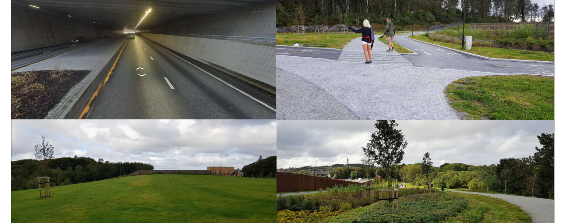
Dæmi um vistlok, frá vegstæði og ofan vegar, með stígakerfi og gróðri
