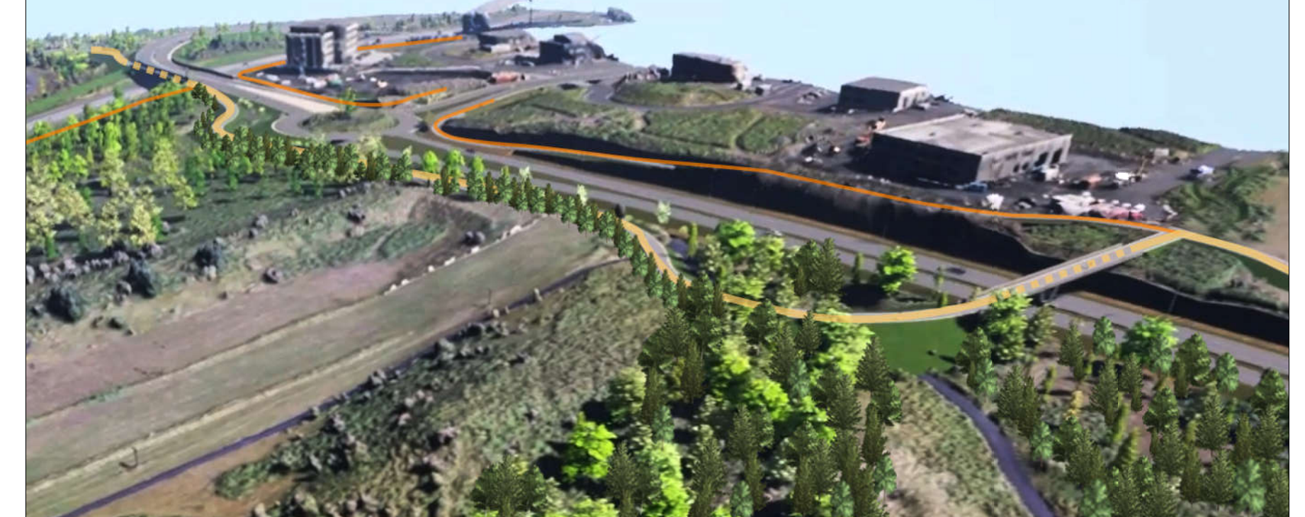
Ásýnd II: Göngu- og hjólabrú yfir Arnarnesveg og stígakerfi séð frá vestri
