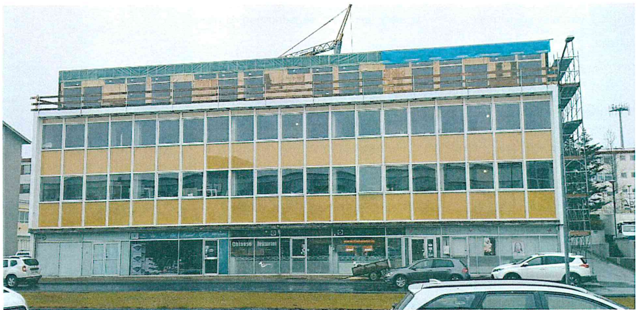
MYND 1 Á myndinni má sjá austurhlið byggingarinnar við Grensásveg 12, 108 Reykjavík.
