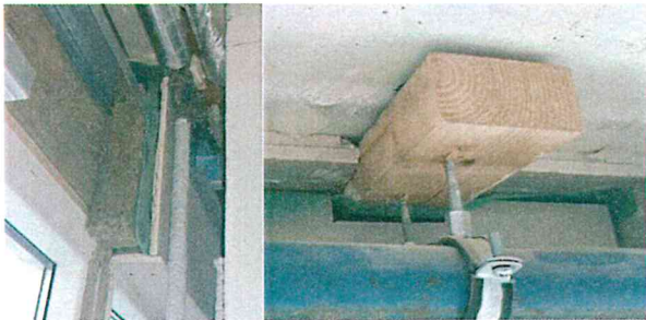
MYND 8 Hér má sjá dæmi um frágang rakasperru í austurvegg.
