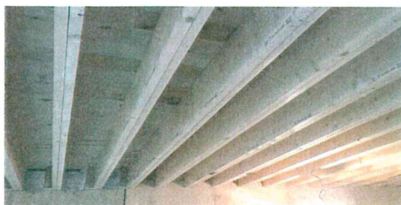
MYND 3 Á myndinni má sjá hvernig þaksperrur liggja þvert á þakhallan. Borðaklæðning liggur beint á þaksperrum og ekki fyrir séð hvernig loftræsta á þakið.
