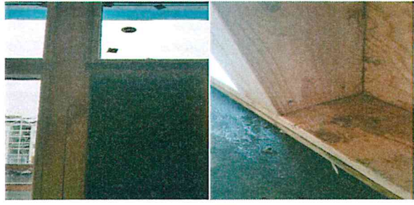
MYND 9 Dæmi um smíðavið í gluggakerfi austurhliðar á 4.hæð sem líklega er sett saman á staðnum.
