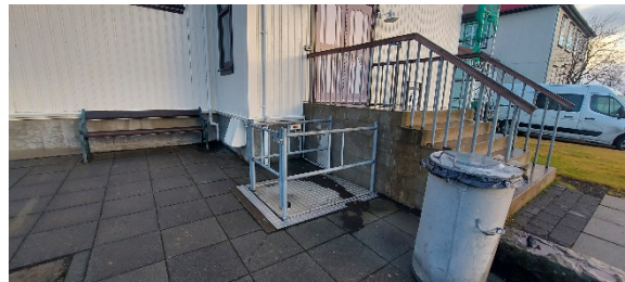
Mynd 2.3-2 Lyfta fyrir hreyfihlaða við inngang ÍR-húss
