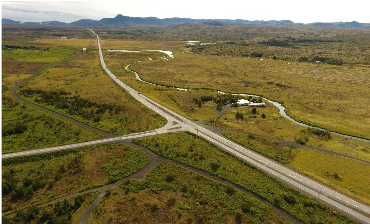
MYND 3.6 Núverandi vegamót við Hafravatnsveg. Mynd: EFLA, 2021.
