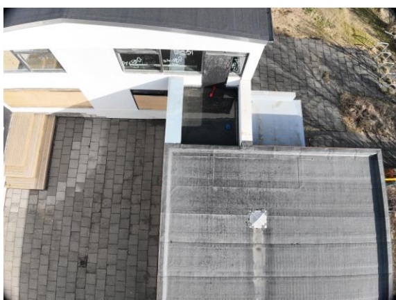
Mynd 5-19: Þaksvalir. Vatn safnast fyrir í svölum og lekur í gegnum steypu inn í hús.
