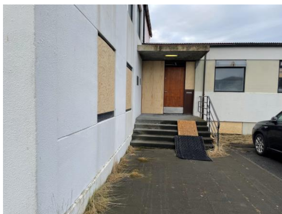
Mynd 5-6: Inngangur á norðurhlið, heft aðgengi fyrir hreyfihamlaða.
