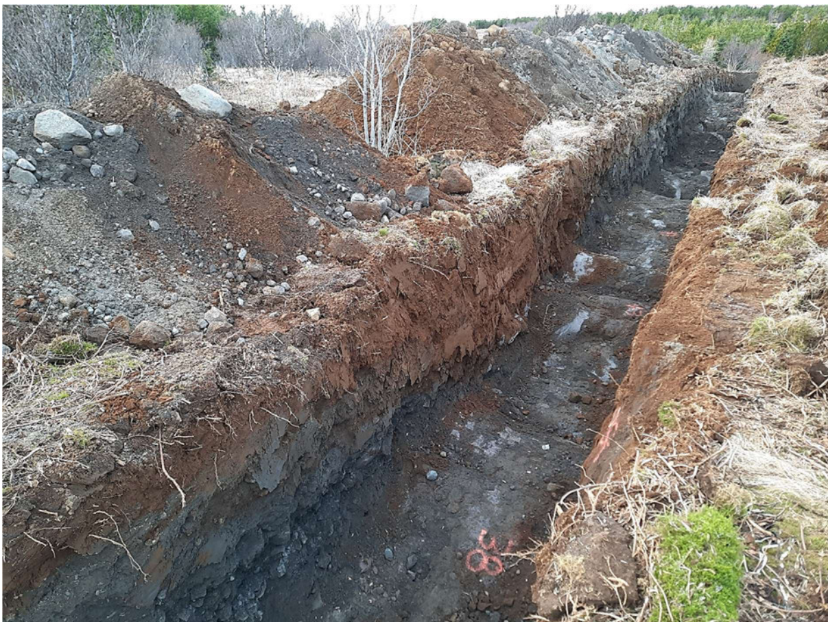
Mynd 4. Horft fram eftir skurði 2 frá stöð 38.
