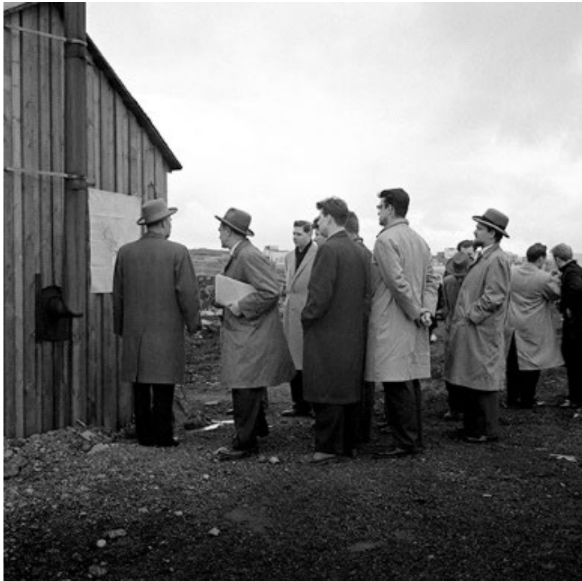
Mynd 7. Framkvæmdir við grunn hússins hafnar og fulltrúar frá bæjaryfirvöldum skoða aðstæður. Mynd tekin í mars-apríl 1960. 27
