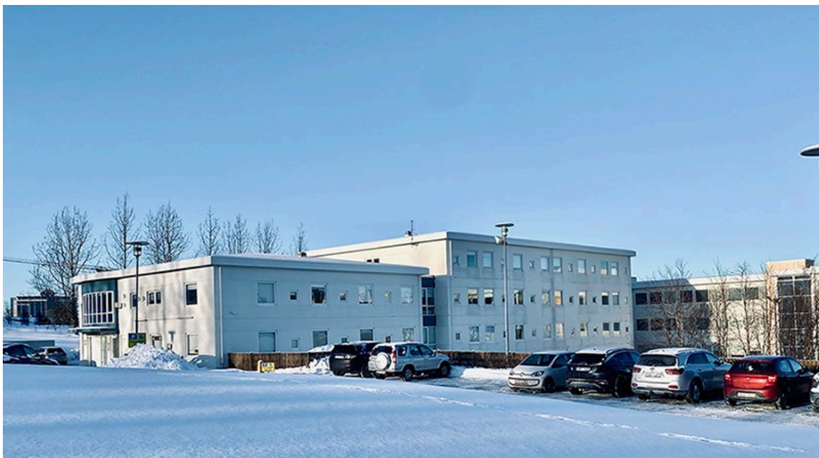
Mynd 17. Horft til norðvesturs yfir fjórða áfanga Íþróttamiðstöðvarinnar. 39
