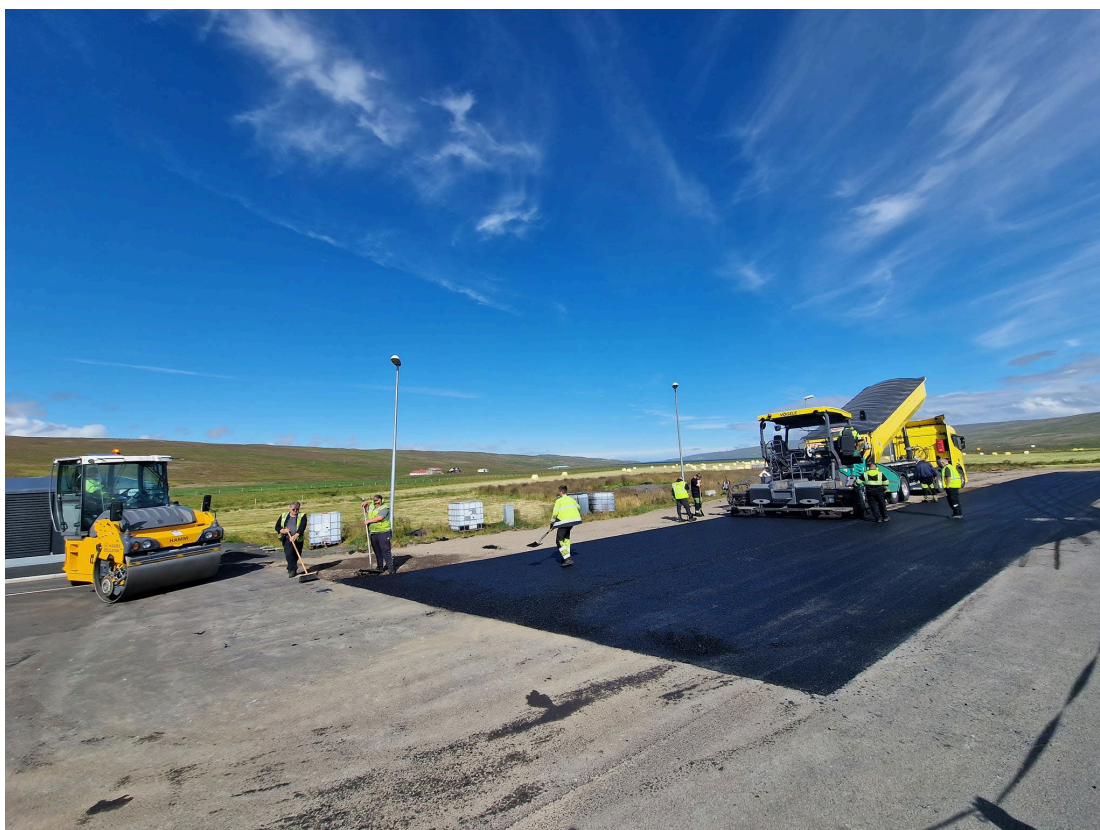
Mynd 3: Unnið við nýlagn í Staðarskála-Hrútafirði
