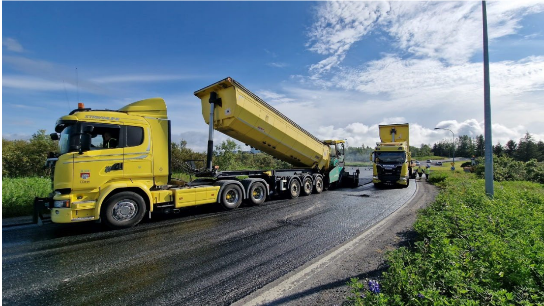
Mynd 1: Unnið við yfirlagnir á stofngötu í Reykjavík
