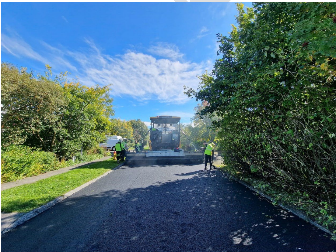
Mynd 2: Unnið við yfirlagnir á húsagötu í Reykjavík
