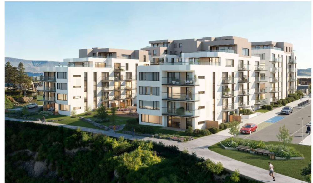
Nýbygging við Eirhöfða 7 þar sem Félagsbústaðir kaupa 5 íbúðir.
