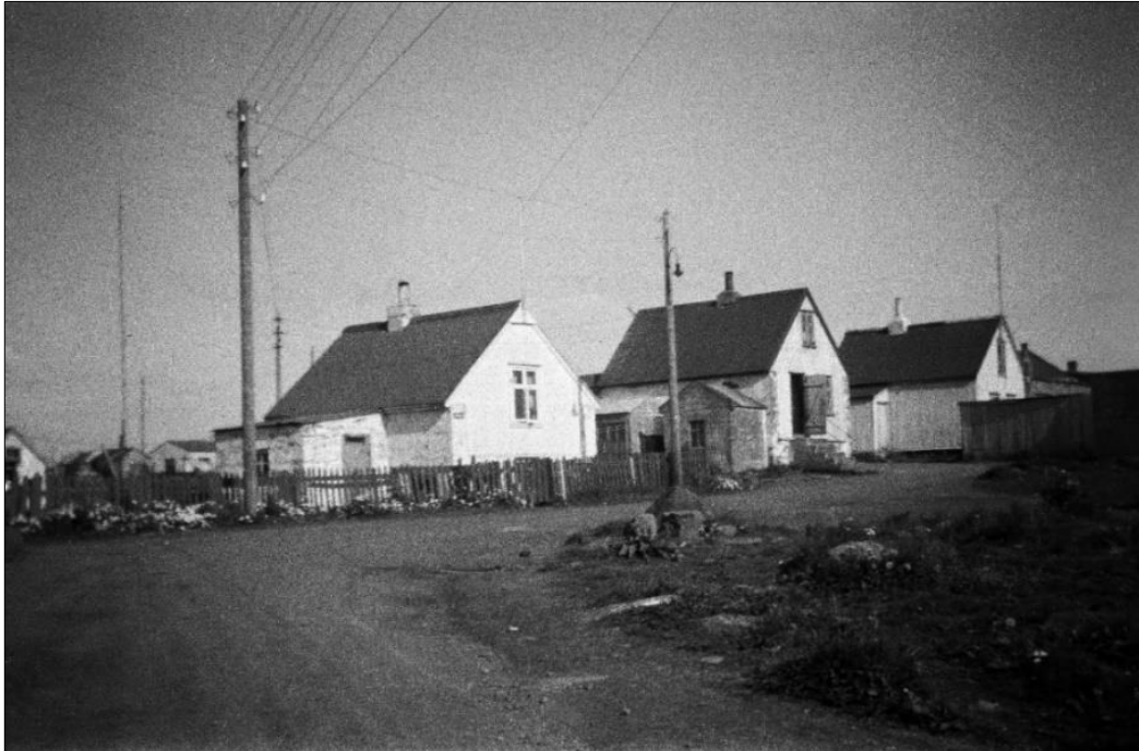
Mynd 4. Ljósmynd tekin frá Súlugötu um 1940-1949. Guðjónshús stendur næst og Jónshús í miðju, þar sem nú eru lóðirnar Tómasarhagi 32 og 34. Húsið fjærst er Björnshús. 22
