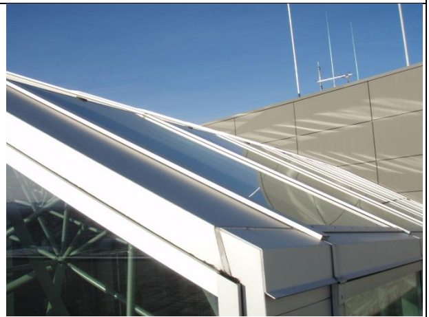
Mynd nr. 4. Tveir austustu þéttlistarnir í norðaustur horni á þaki glerhjúpsins hafa sigið niður um 3 cm. Laga þarf þá og festa. (1)
