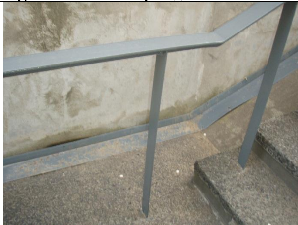
Mynd nr. 7. Áfelling milli húss og stiga eru ekki þéttar. Yfirfara þarf þær og laga. (1)
