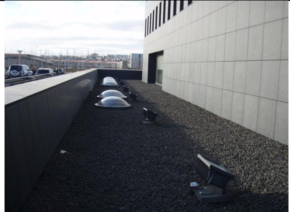
Mynd nr. 4. Fín mól er ofan á einangrun þaks yfir kjallara - 1. hæðar. Setja þarf grófari mól eða hellur í hennar. (2)
