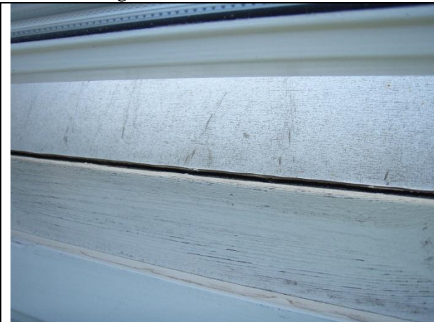
Mynd nr. 1. Rifur eru milli áfella og botnstykkja glugga og þar á vatn greiða leið á milli. Kítta þarf í þessar raufar. (2)
