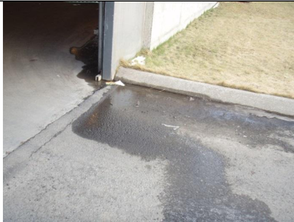
Mynd nr. 3. Allt vatn úr rampa framan við innkeyrslu-hurðina rennur inn undir hurðina og eftir bílgeymslunni að niðurfalli sem er við næstu súlu. Setja þarf svelg utan við hurðina. (1)
