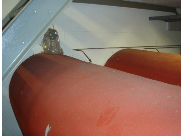
Mynd nr. 3. Flóðavörn vantar í kringum hitaveitupípur við stökkenda sem tengjast stöðinni. (1)
