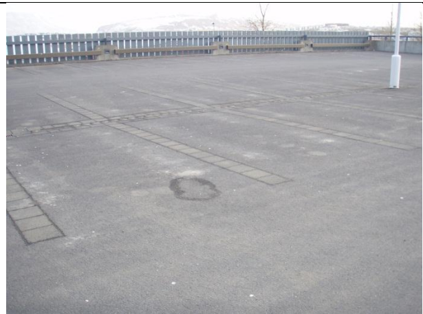
Mynd nr. 8. Hellur eru feldar niður í malbik á þaki hússins og því kemst vatn greiðlega undir malbikið. Lagt er til að malbikað verði með lituðu malbiki í raufarnar. (2)
