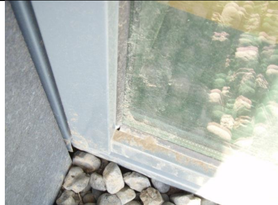
Mynd nr. 3. Víða eru göt við enda á láréttum botnlistum og þar kemst því vatnið auðveldlega inn. Kítta þarf í þessi göt. (1)
