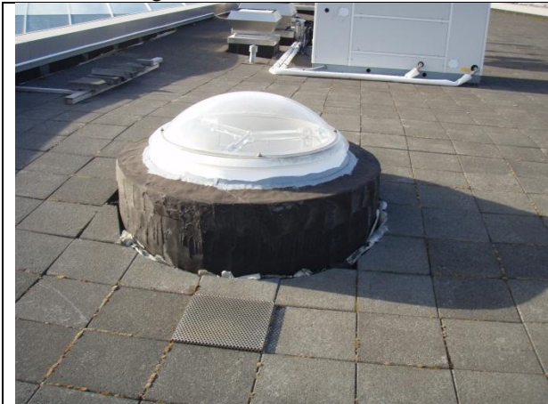
Mynd nr. 1. Plastlúga er yfir ofanljósi upp úr hringstiga í norðurhluta hússins. Plastið er svagt og því lyftist það í óveðrum. Styrkja þarf lúguna (1)
