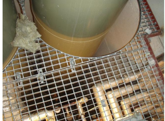
Mynd nr. 2. Rifur eru víða milli lagna og rimlagólfa í lagnastokkum. Setja þarf lok yfir þessar rifur. (1)
