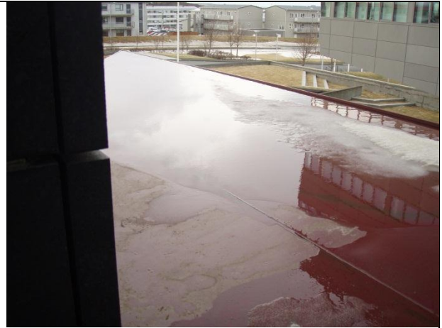
Mynd nr. 2. Vatnspollur situr ofan á skyggni. Hreinsa þarf niðurföll til að veita vatninu burt. (1)
