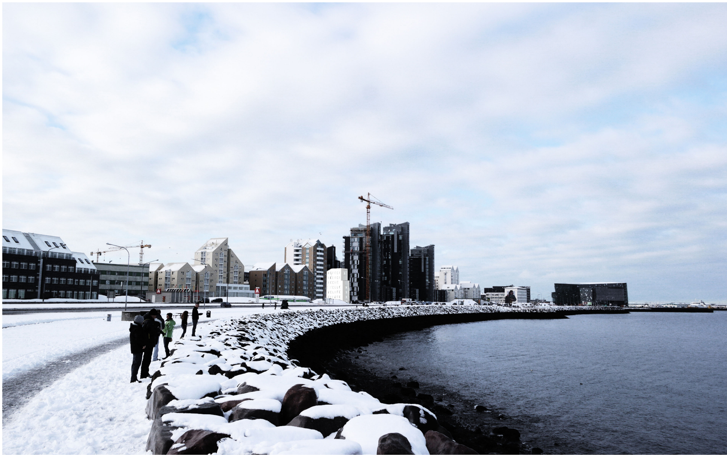
HÖRFT AÐ SKIPULAGSSVÆÐI FRÁ GÖNGUSTÍG VIÐ SÆBRAUT AUSTANVERT.
