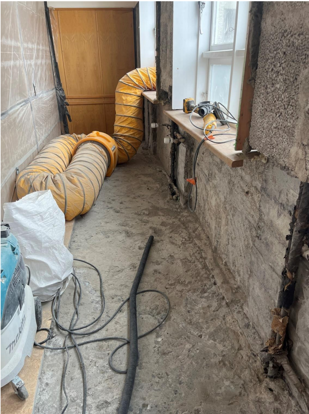
Útsogsblásarar með HEBA filterum notaðir til að blása framkvæmdaryki út um glugga. Laugarnesskóli 2023
