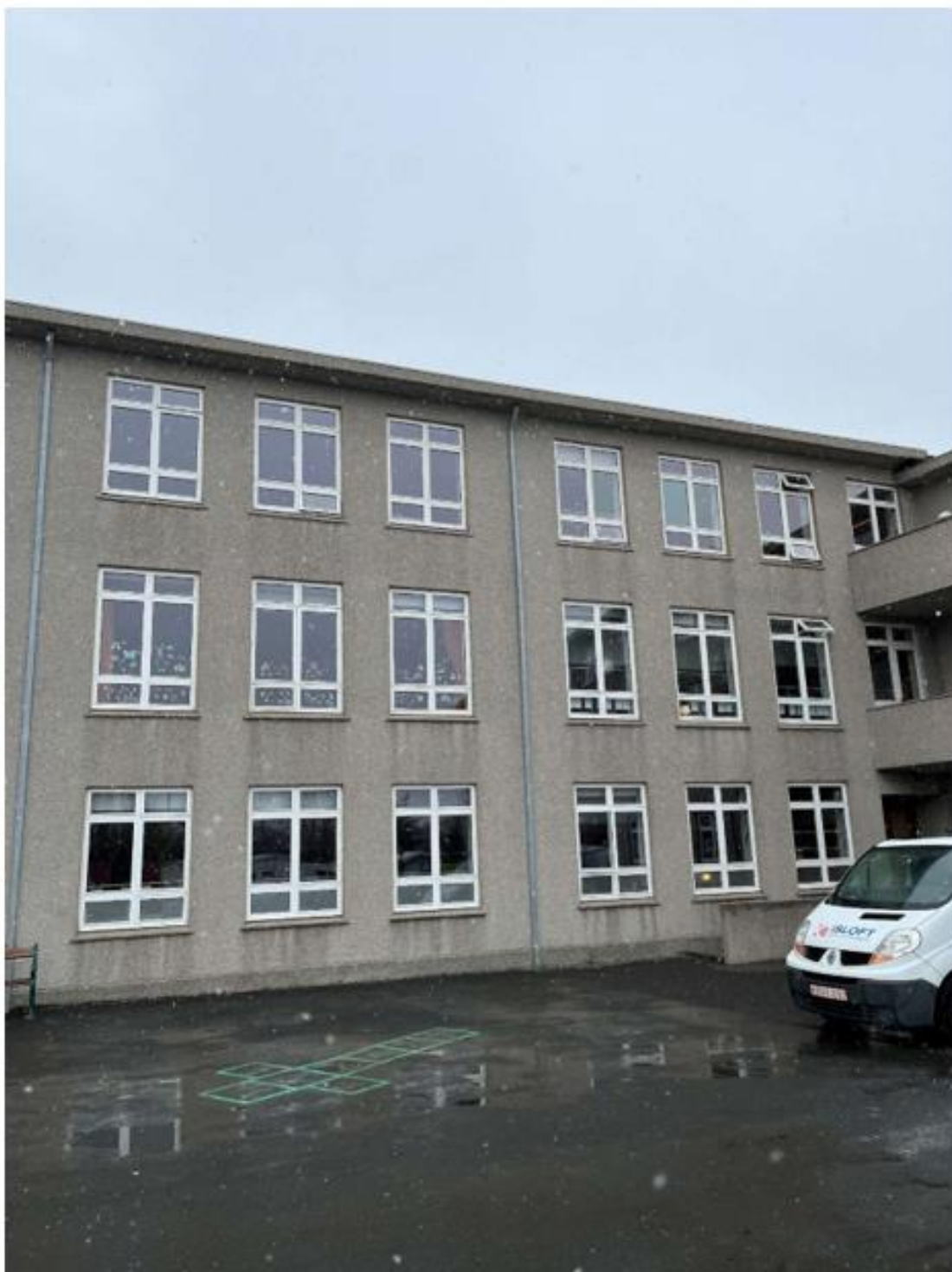
Mynd 59A. Þeldri álmur. Fillcoat efni borið í kringum glugga til að koma í veg fyrir leka.
