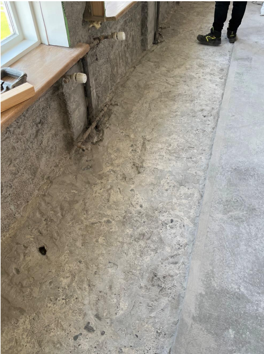
Búið að brjóta gólf upp. Laugarnesskóli 2023
