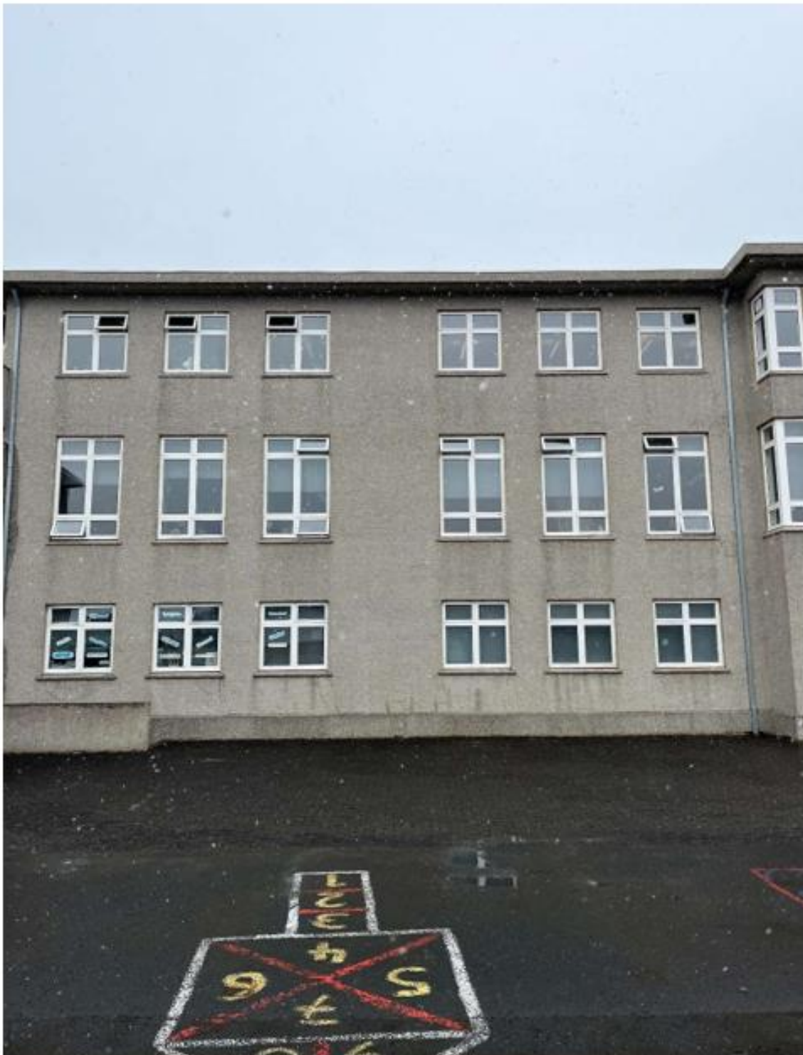
Mynd 60A. Hlið stjórnenda álm, Fillcoat efni borið í kringum glugga til að koma í veg fyrir lek
