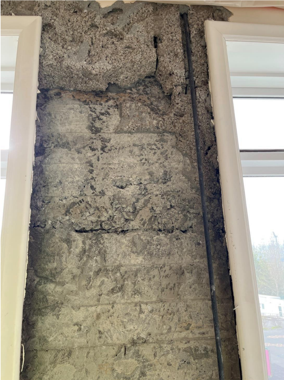
Allt mengað efni losað úr rýmum út um glugga. Laugarnesskóli 2023
