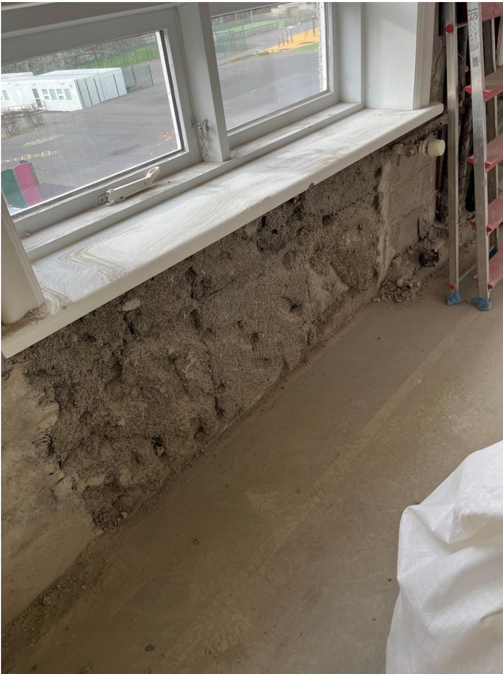
Einangrun og múr rifin af veggjum. Gólf brotið upp. Laugarnesskóli 2023
