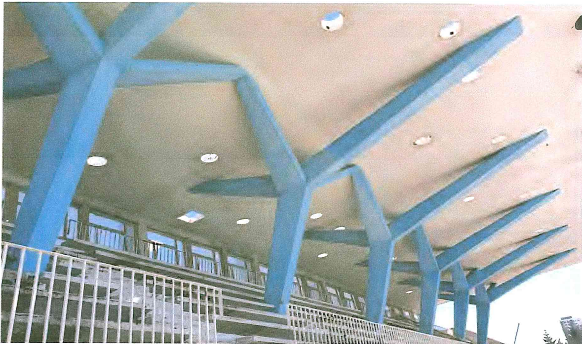
Mynd 2. Horft upp stúkuna og upp undir skyggnið. Skyggnið er borið af blámáluða burðarvirkinu og einnig af þeim hluta rammans sem tengist bakveggnum (hinum megin við gluggana).
