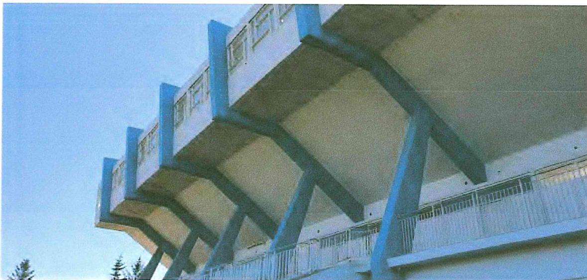
Mynd 3. Horft aftan á stúkuna vestan megin. Rammar á bakvegg eru samfelldir að efstu brún skyggis. Hér má sjá hvernig rammarnir hafa verið klæddir af á veggglutanum til þess að verja þá gegn regnvatni.
