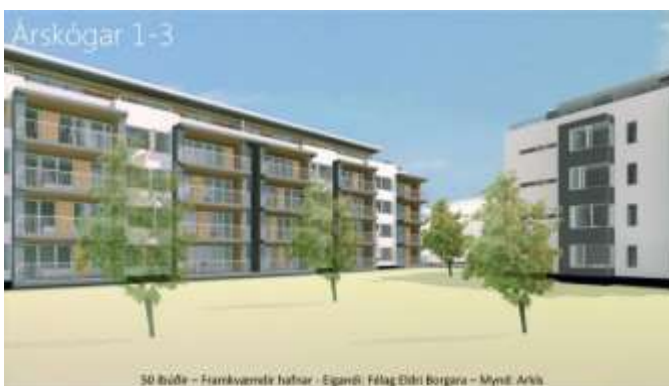
Húsnæðisáætlun: Byggingarsvæði á framkvæmdastigi
