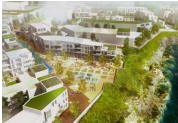
Húsnæðisáætlun: Byggingarsvæði á framkvæmdastigi
