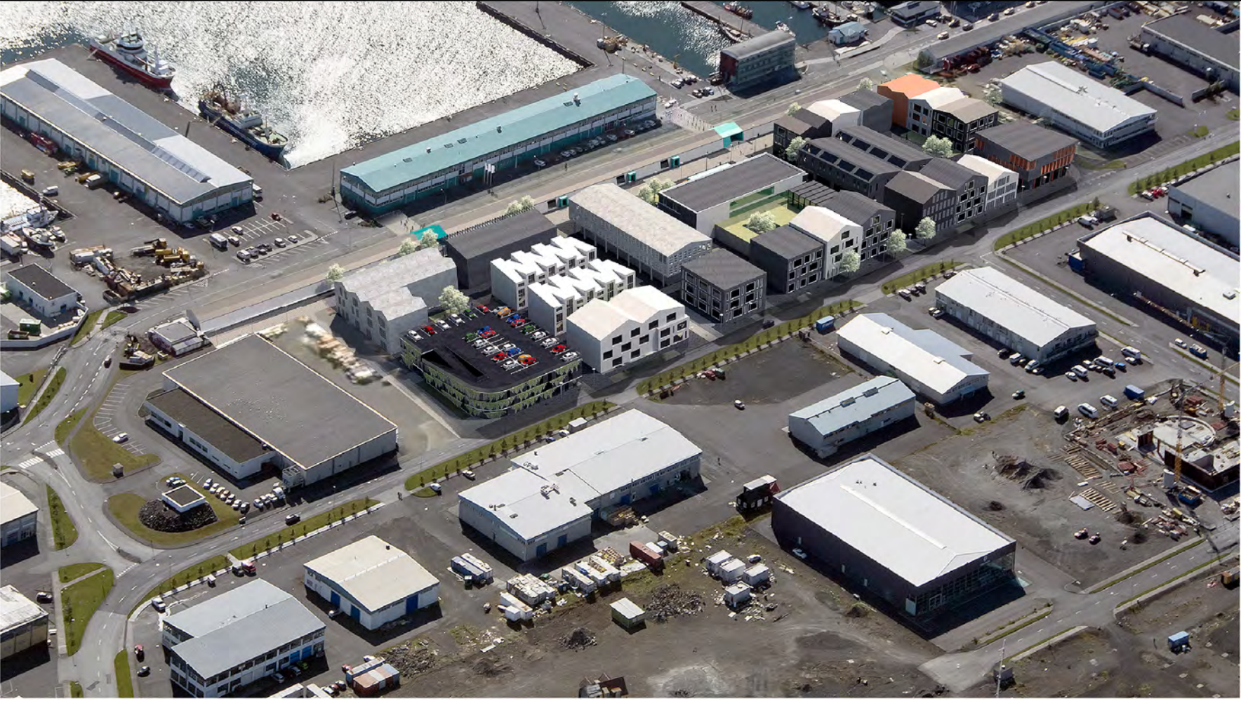
Yfirlitsmynd - horft til suðurs
