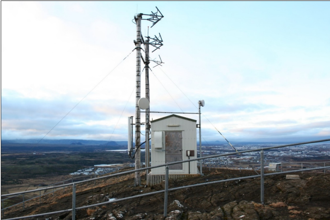
Mynd 2. Fjarskiptabúnaður sem er á svæðinu, tækjarými, tveir staurar með loftnetum og til hægri má sjá spennir, horft í suðvestur.
