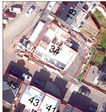
Nýlendugata 34 Framkvæmdir í gangi
