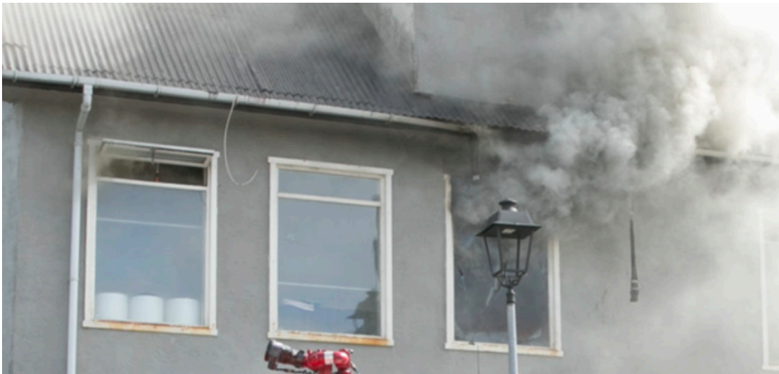
Mynd 8. Reykur smýgur yfir í nærliggjandi rými. Vesturhlið að Bræðraborgarstíg.
