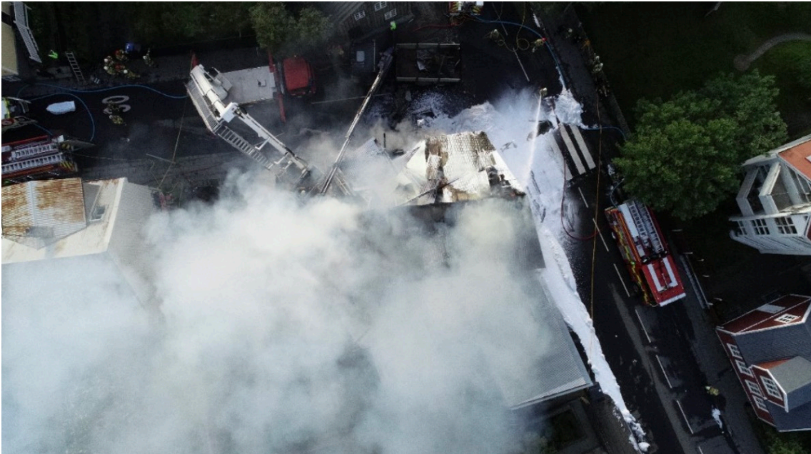
Mynd 16. Myndin sýnir vettvanginn um kvöldið eftir að byrjað var að rífa þak hússins.
