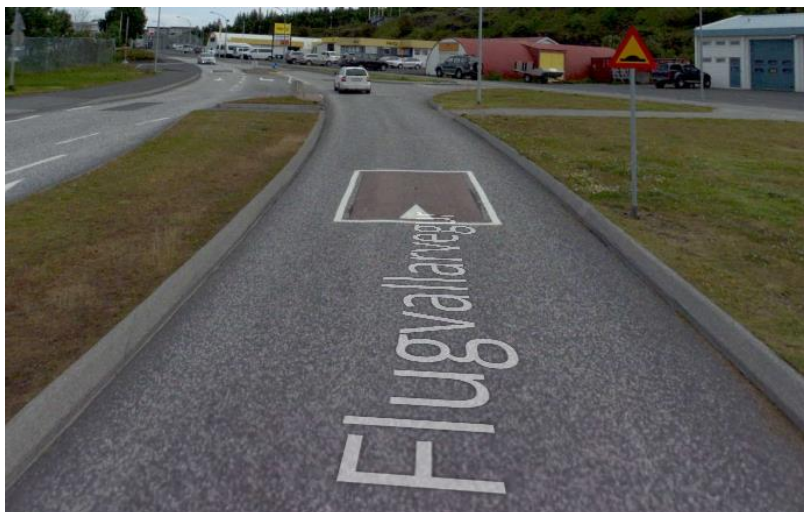
Mynd 4 Hraðahindrun (púði) sem skal fjarlægð
