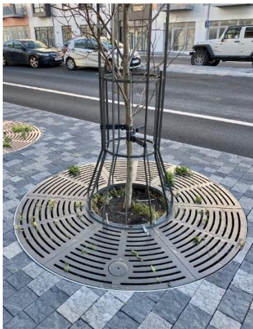
Myndin sýnir grind sem stuðning við tré, ristin er sambærileg nema ferköntuð í stærðinni 1500x1500mm
