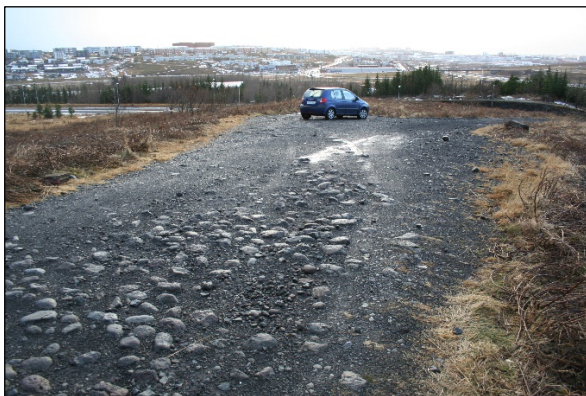
Mynd 21. Úlfarsfellsvegur, horft í suðvestur.
