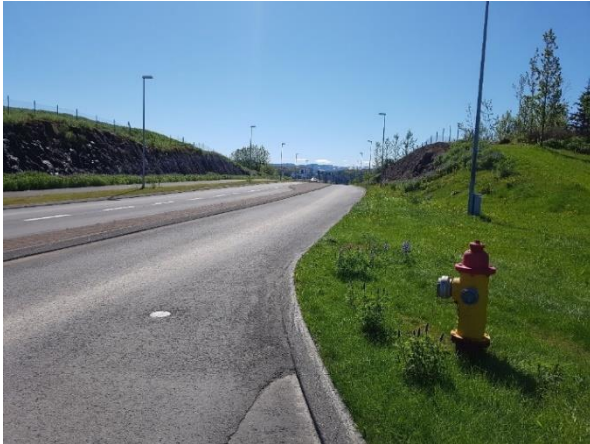
Mynd 5: Lambhagavegur. Í tillögu 2 er gert ráð fyrir að leggja strenginn fyrst vestan megin við veginn en síðar er vegurinn krossaður vegna lagna sem þar eru fyrir.
