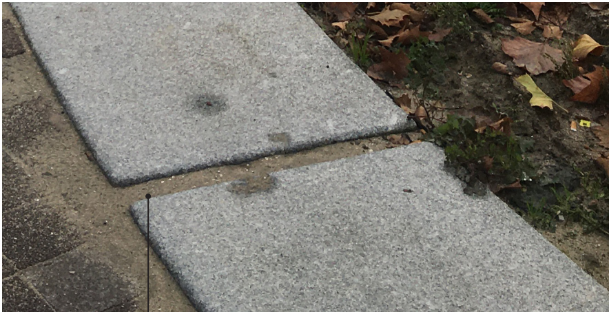
dæmi: frárennslisrás í kantsteinum
