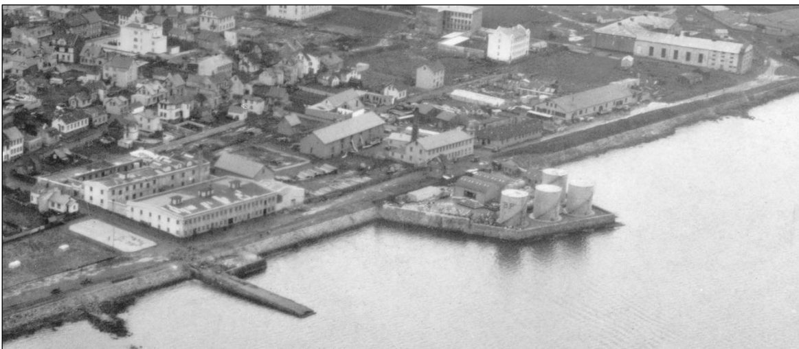
Mynd 10. Loftmynd af byggðinni við Skúlagötu, horft í vestur, árið 1930. Sjóvarnargarður er með allri Skúlagötunni, en líklega hefur grjótið úr gömlu bryggjunum sem voru þar við ströndina verið notað í garðinn. Hluti af Kveldúlfsbryggjunni stendur þó enn og búið að hlaða veglegan varnargarð fyrir Óliustöðina á Klöpp. 26
