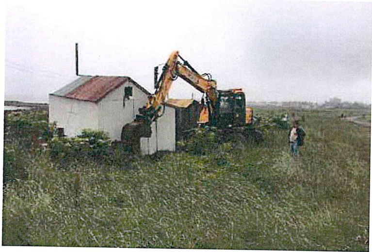
Unnið að hreinsun upp úr skurði 4.
