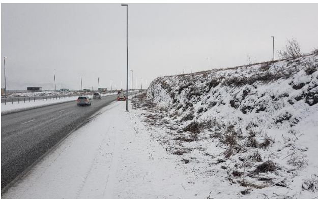
MYND 1 Vegskering meðfram Vesturlandsvegi, horft til norðurs í átt að Korpu (A0).
