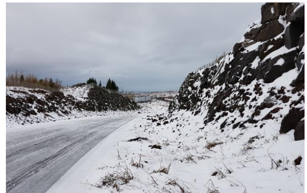
MYND 6 Vegskering á Hólmsheiðarvegi, horft til vesturs.
