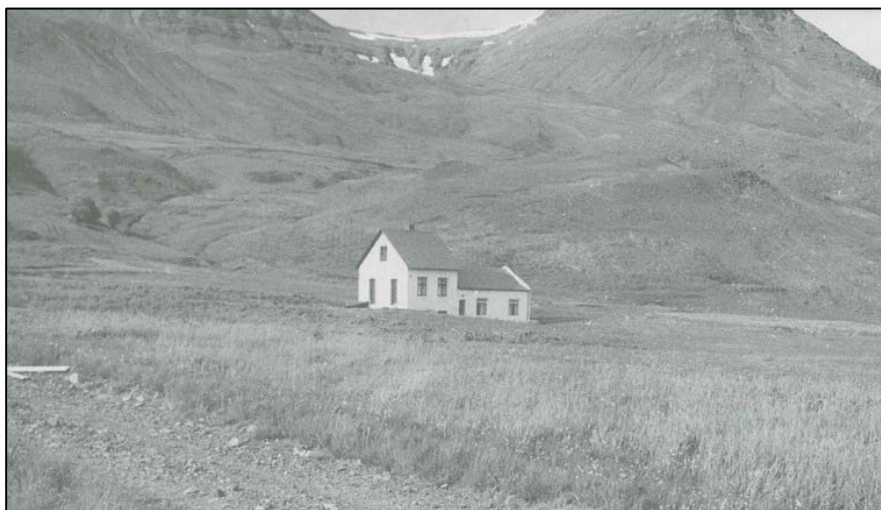
Mynd 9. Mógilsá 1965-1970 búið að rífa öll útihúsin, en íbúðahúsin voru rifin líklega árið 1970. 51
