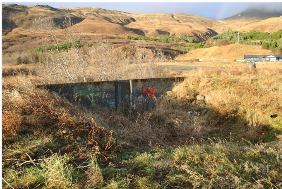
Mynd 23. Árið 1965 var farvegi Mógilsár breytt og áin leidd í Tjörnina, stífla var notuð til að stjórna rennslinu.
