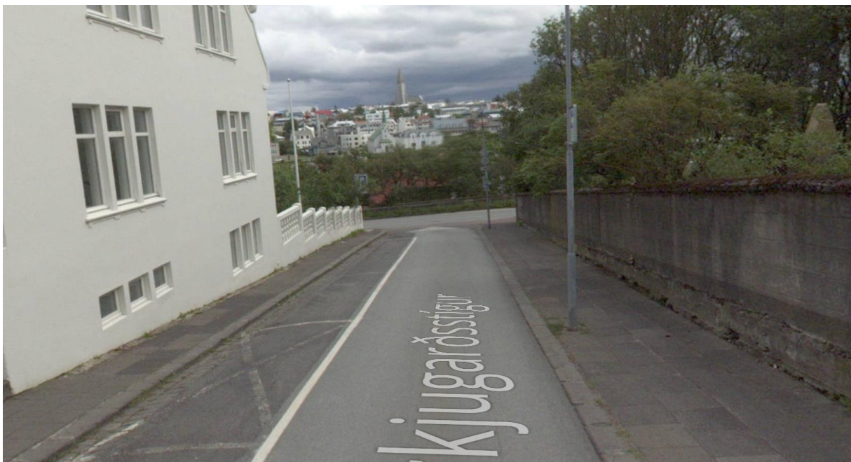
MYND 9 Skjámynd af göturýminu við Kirkjugarðsstíg, séð á móti einstefnu.
