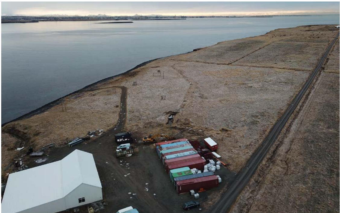
Úttektarreitir C, drónamynd tekin árið 2020, áður en framkvæmdir hófust á reitnum. Horft til SSV
