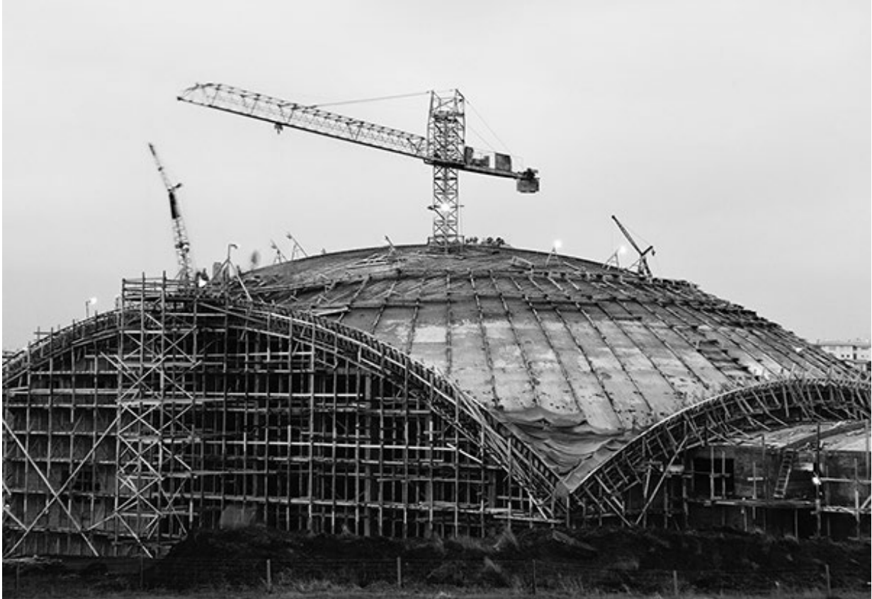
Mynd 12. Laugardalshöll í byggingu. Mynd tekin í september 1963. 32
