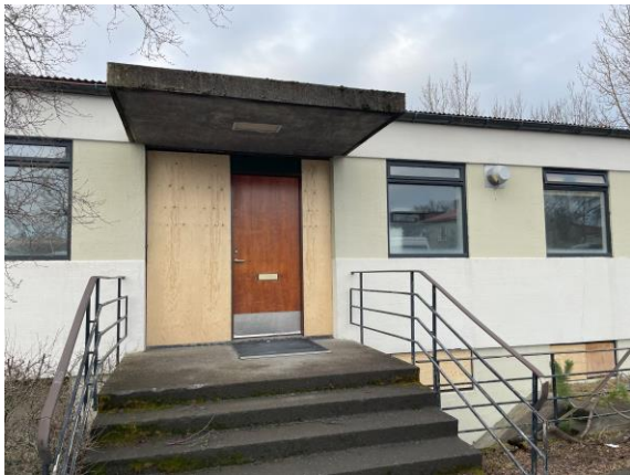
Mynd 5-7: Norðurhlíð, inngangur í álmu a. Þakskyggni veðrað.
