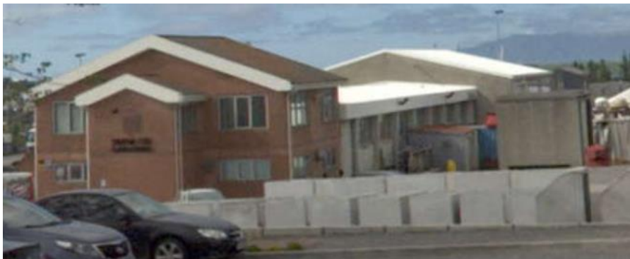
Mynd 13 – Bildshöfði 7 Verkstæði og starfsmannaðastaða, bygging sem verður fjarlægð.
